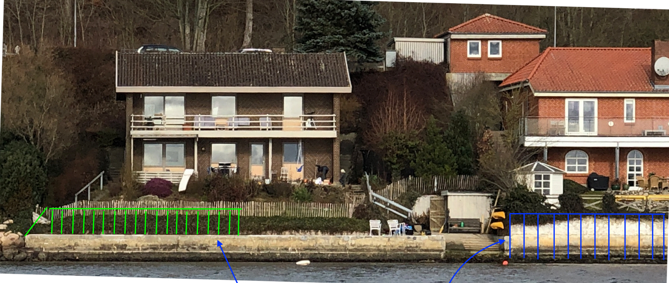
Ny støttemur i skel mod fjorden
